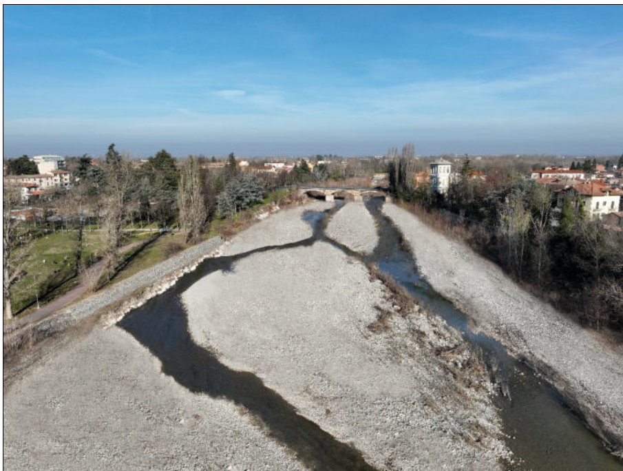
Fotoinserto opere di pulizia dell'alveo e realizzazione di gabbionata n.1
