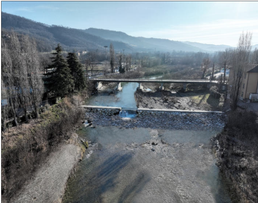
Fotoinserto opere di pulizia dell'alveo e realizzazione soglia in massi cementati
