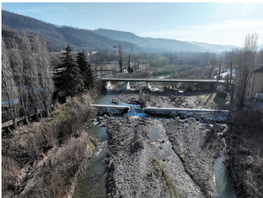
Vista dell'alveo del Torrente Staffora, del ponte che conduce a Salice Terme e della briglia in calcestruzzo
