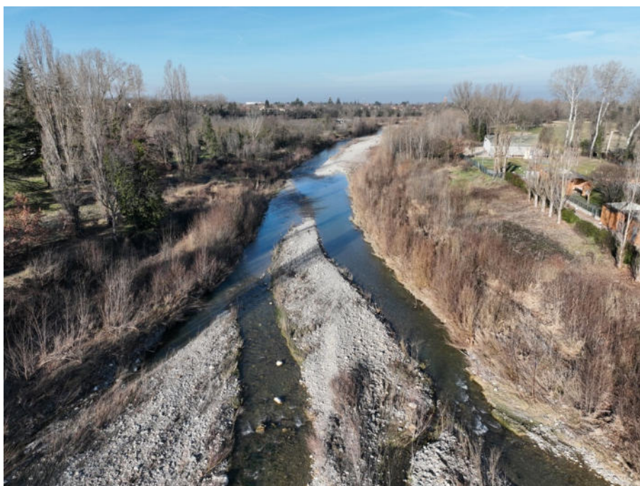
Vista dell'alveo del Torrente Staffora a valle del ponte che conduce a Salice Terme e della briglia
