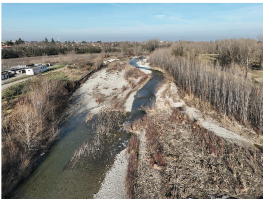
Vista dell'alveo del Torrente Staffora in prossimità del depuratore
