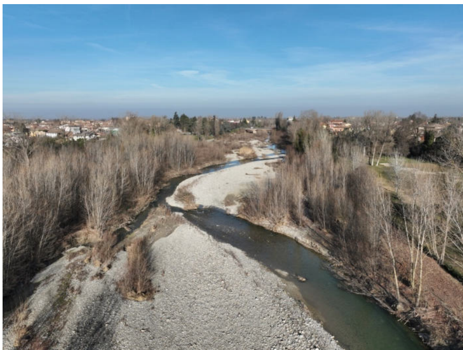
Vista dell'alveo del Torrente Staffora a valle della briglia in calcestruzzo e dello sbocco del Cavo Lagozzo
