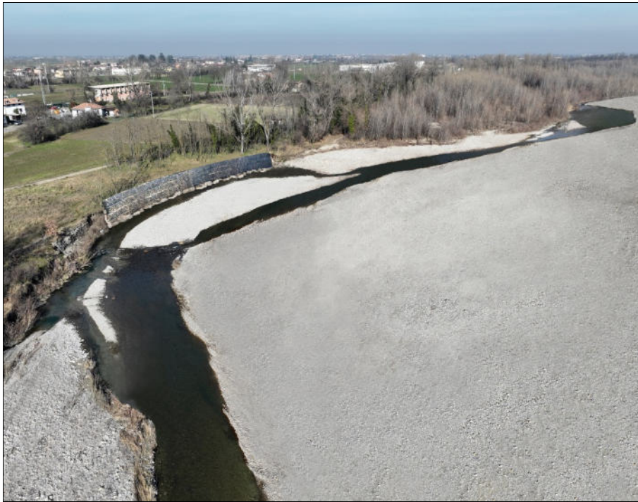
Fotoinserimento opere di pulizia dell'alveo e realizzazione di gabbionata n.2
