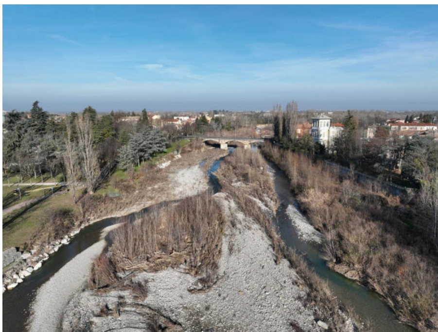
Vista dell'alveo del Torrente Staffora a monte del ponte che conduce a Rivanazzano Terme con fenomeni erosivi in sponda sinistra
